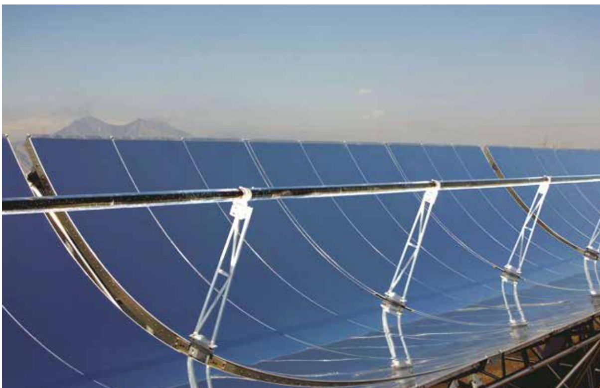
FOTOGRAFÍA 5. CCSP de cilindro parabólico
