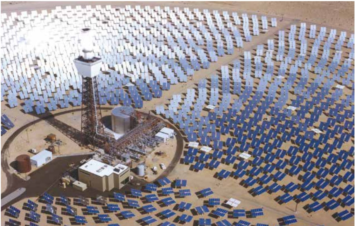
FOTOGRAFÍA 7. CCSP de torre de concentración
