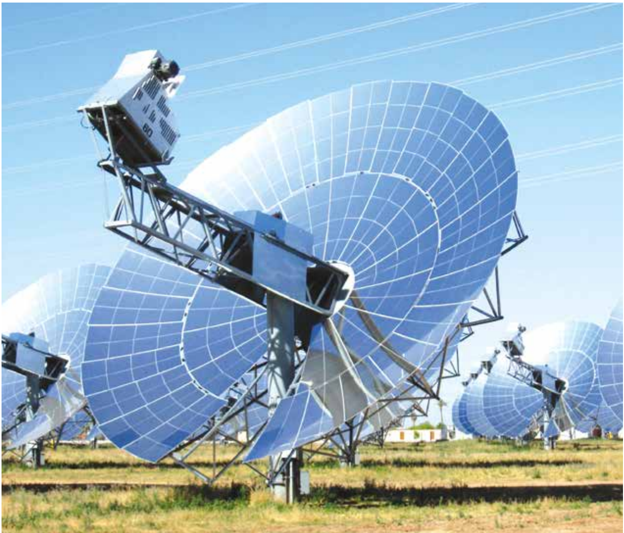
FOTOGRAFÍA 8. CCSP de disco parabólico
