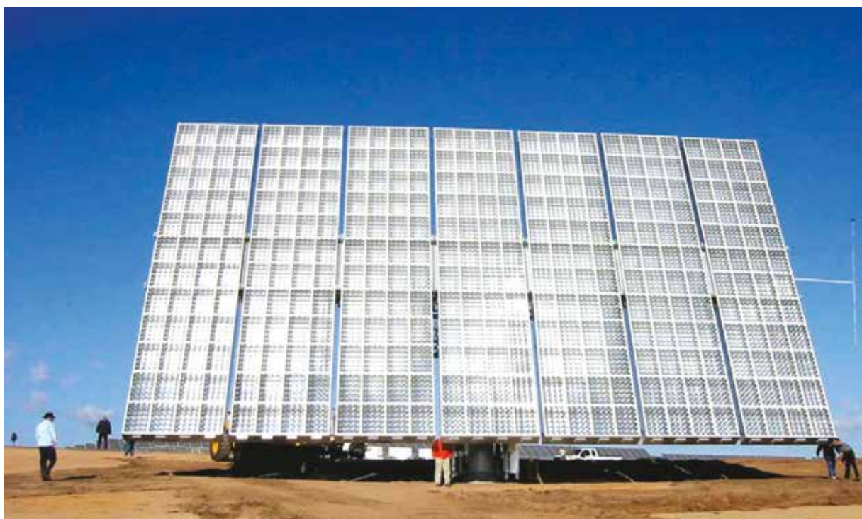
FOTOGRAFÍA 4. Panel de concentración fotovoltaica
