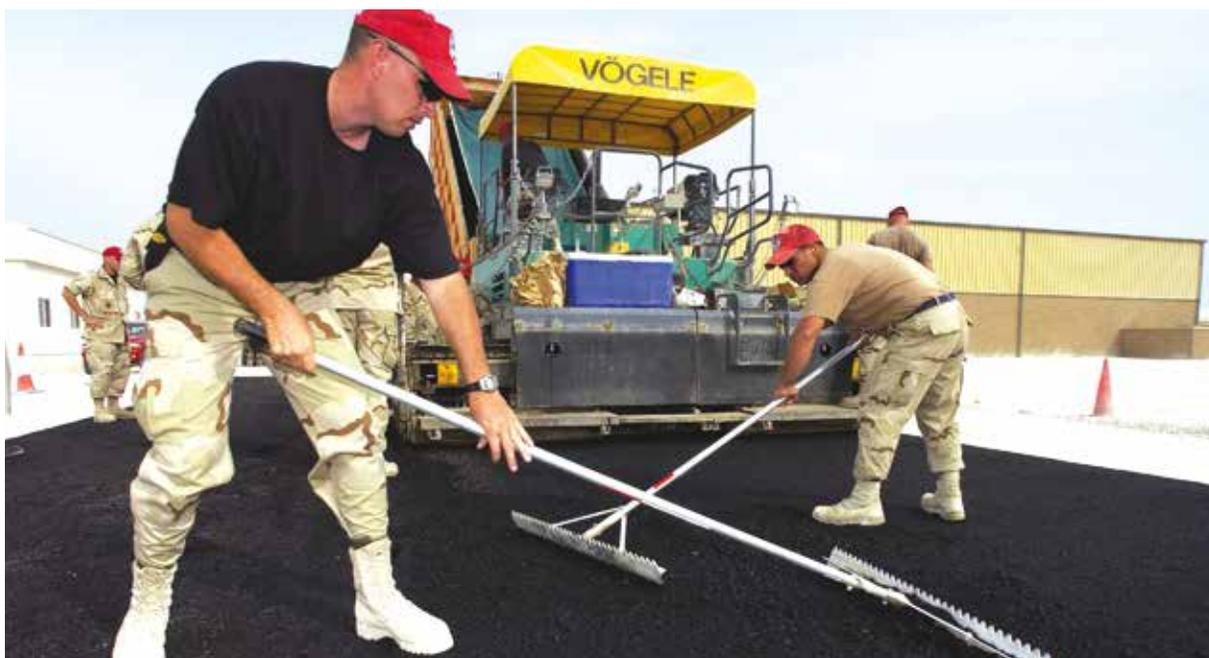
**FOTOGRAFÍA 5. Aplicación de una carpeta delgada de asfalto en caminos de tierra o ripio**
